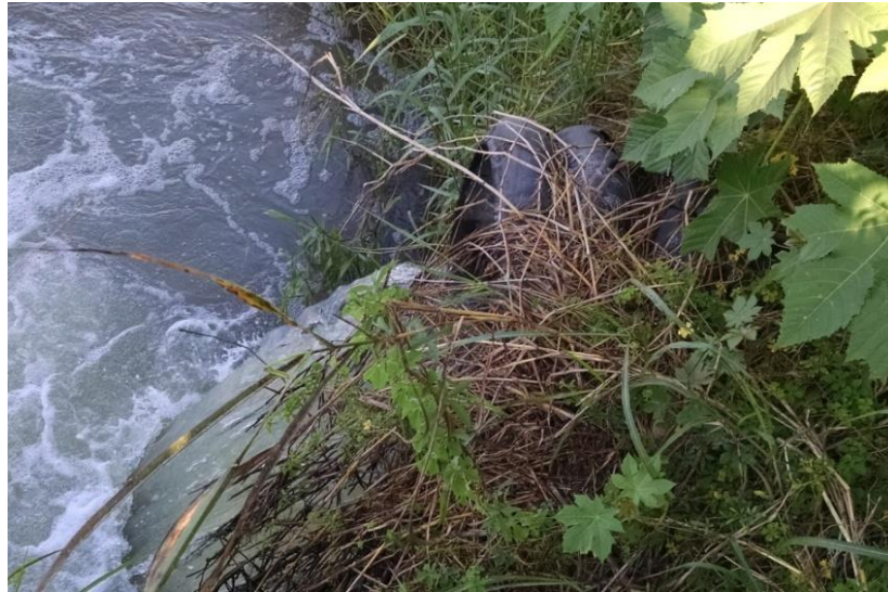
Figura 2. Descarga planta de tratamiento
